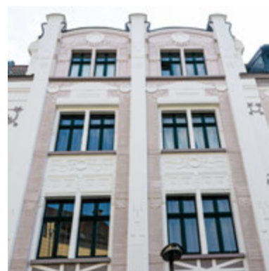
Die renovierte Hausfassade an der Rolandstraße.
